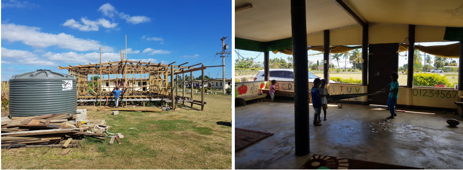
주: 잦은 홍수에 대비한 Lovu Hart Kindergarten 건물 신축 및 내부 모습
