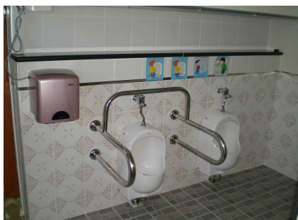
[사진 IV-2-15] 장애아 겸용 소변기 및 핸드드라이
