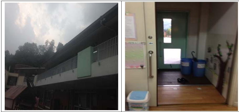
[그림 IV-2-12] CA유치원의 2층 테라스식 대피로 및 교실의 외부출입문
