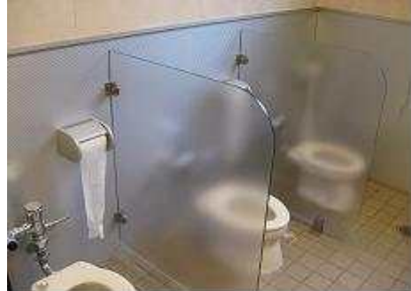
R보육시설 유아용 화장실
