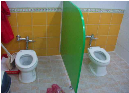
F어린이집 화장실 사진
