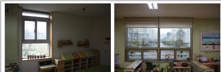
[그림 V-3-34] 2층 이상에 설치된 추락방지 창문 사례 (20.2 관련)
