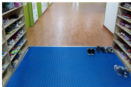
[그림 V-3-23] 주출입구 단차제거 및 미끄럼 방지 매트 설치 (13.2 관련)
