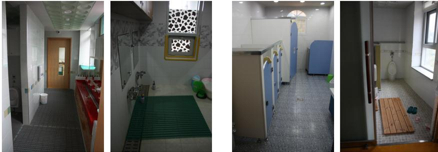
[그림 V-3-6] 미끄럼방지 바닥매트 설치 사례(8.3 관련)
