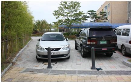
[그림 IV-3-44] 놀이터와 주차장 사이 차량통제용 볼라드 설치
