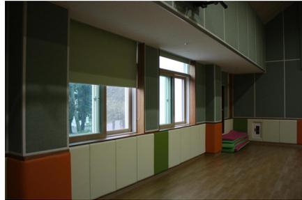
[그림 IV-3-23] 다목적실 벽 충격방지 완충재 설치
