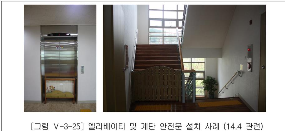
[그림 V-3-25] 엘리베이터 및 계단 안전문 설치 사례 (14.4 관련)
