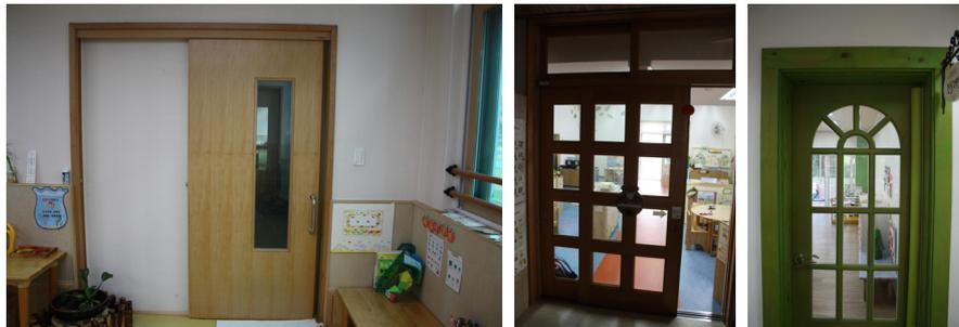
[그림 V-3-33] 영유아 눈높이를 고려한 창 설치 출입문 (19.4 관련)
