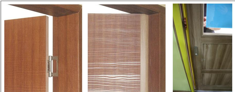
[그림 V-3-32] 출입문 경첩부분 커버보호대 및 모서리 끼임방지 완충재 설치 사례 (19.3 관련)
