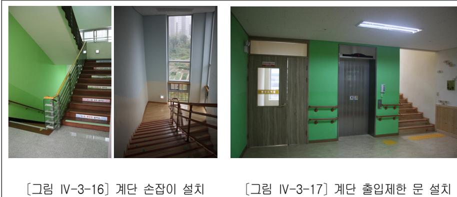
[그림 IV-3-16] 계단 손잡이 설치
